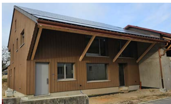
Magasin à la ferme, situé à Coinsins Les parties d'ouvrage suivantes sont composées à 92.8%, soit au total 66.03 m3, de bois certifié Label Bois Suisse
