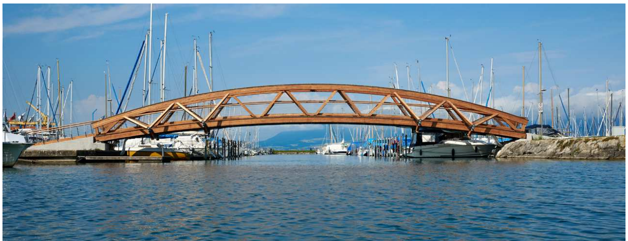
Passerelle piétonne à Delley Portalban (FR)
