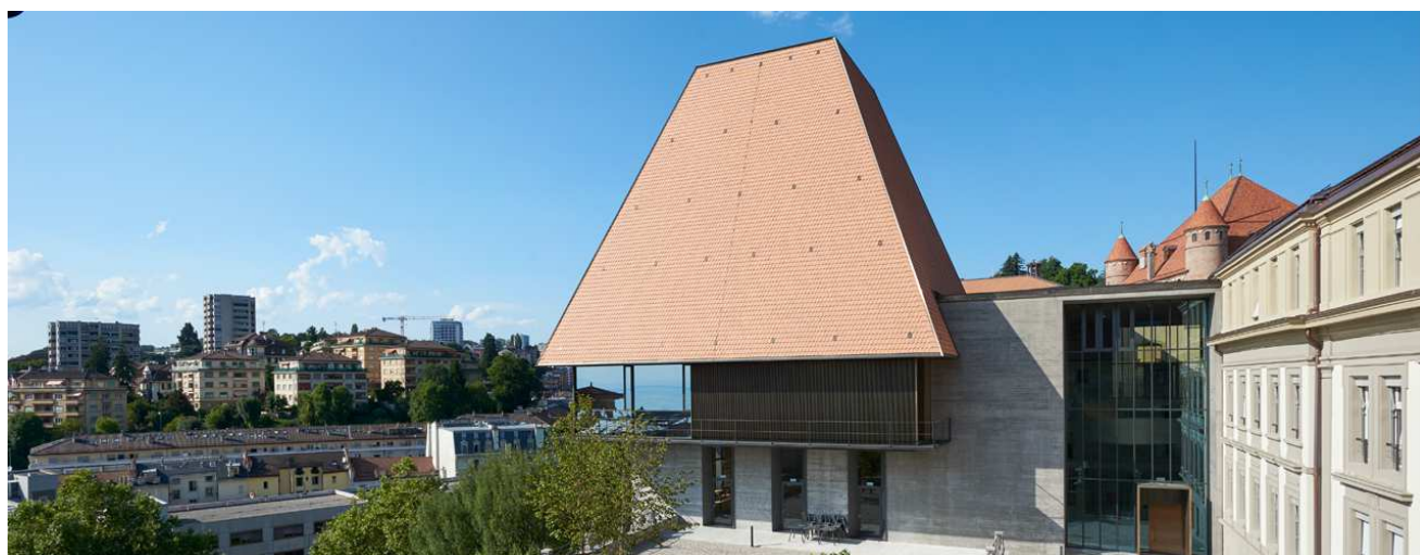
Toit du parlement vaudois, Lausanne (VD)
